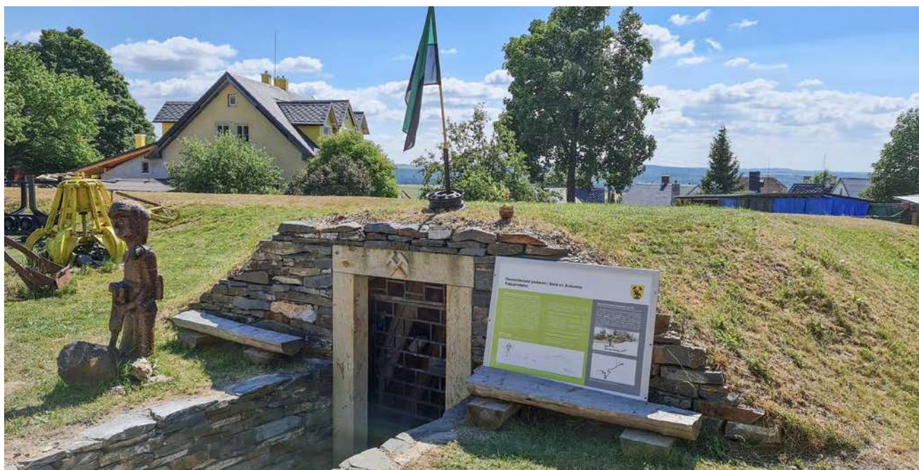
Obr. 2 Nově vybudovaný portál do podzemí (Úpadnice na Staré patro)
