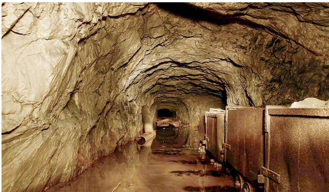
Obr. 4 Současný stav důlního díla – důlní chodby – Severního překopu
