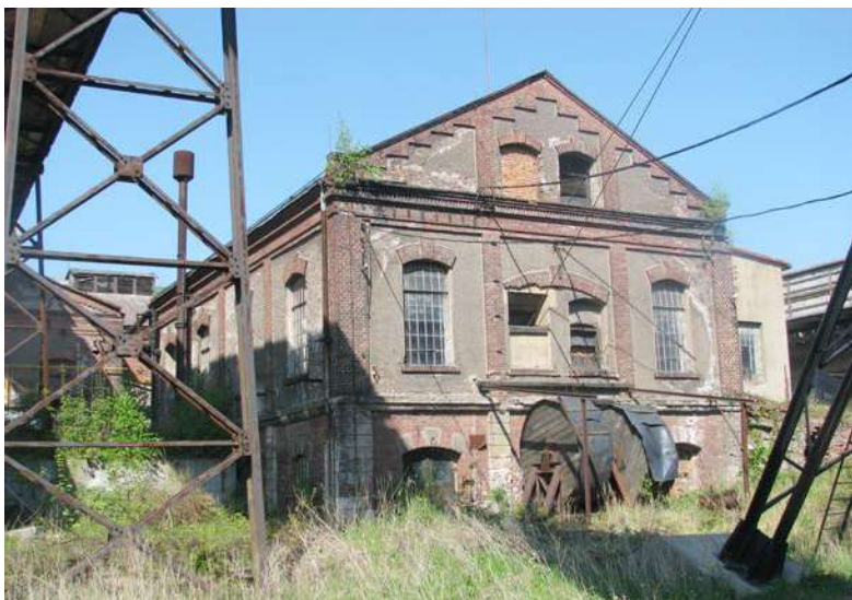
Strojovna jámy Julie od šachetní budovy
