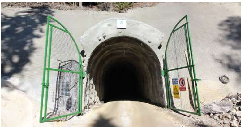
Obr. 20 Nová dopravní štola na úrovni 1490 m n. m.
