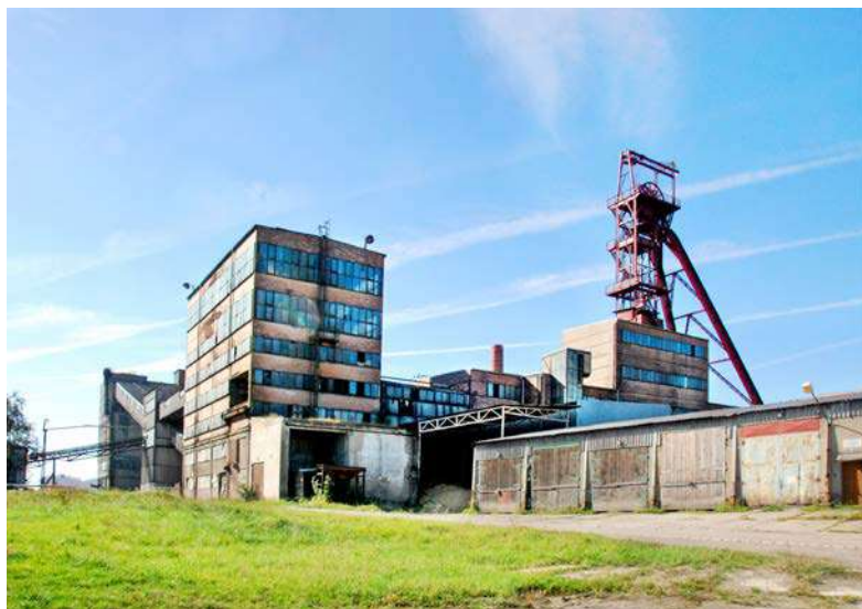
Pohled od SV na úpravnu, těžní věž se šachetní budovou jámy Jan
