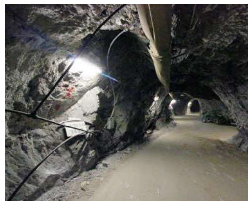
Obr. 22 Úpadnice na úrovni 1457 m n. m.
