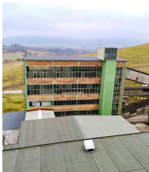
Úpravna uhlí po opravě objektu 2019 - pohled z těžní věže
