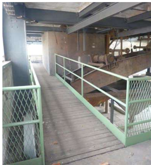
Úpravna uhlí - nová lávka pro vozíčkáře
