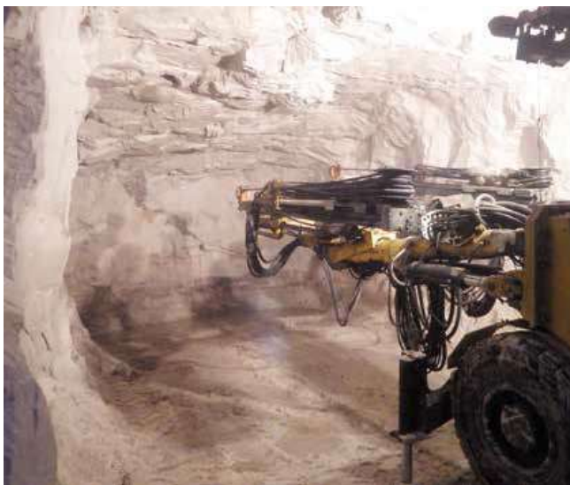
Obr. 6 Postup vrtacích prací v těžební komoře
