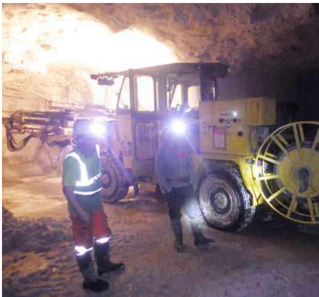
Obr. 5 Vrtací vůz Atlas Copco
