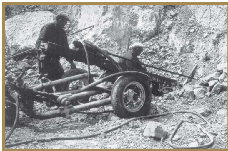
Provádění vrtacích prací na lomu Holý Vrch v 30. letech 20. století.
