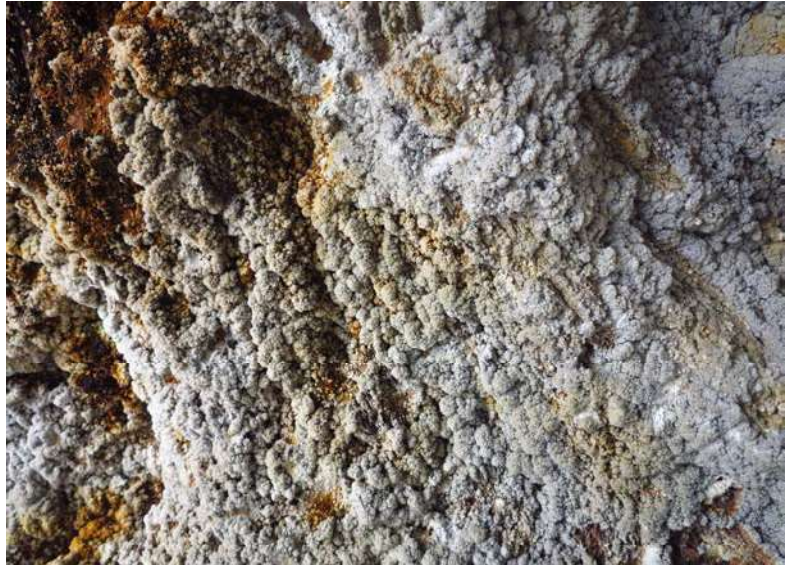
Solné výkvěty na stěně štoly u Purpurového jezírka.
