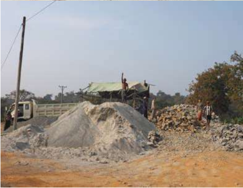
Štěrka je vyráběna přímo u opravovaných úseků silnic.
